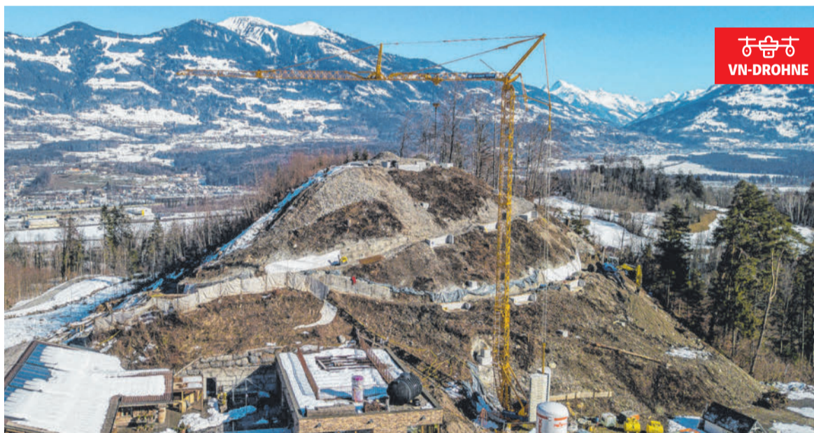
Der 23 Meter hohe Hügel wird nach Fertigstellung der Chalets wieder begrünt, naturschutzgeschützte Sträucher rückversetzt. VN/STEUER
